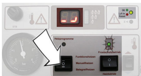
Afbeelding: Programmekeuzeschakelaar op "I" of "II" zetten
