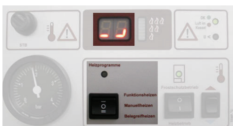
Afbeelding: Bedieningspaneel Programmaschakelaar / display Handmatig verwarmen en Verwarming legklaar maken
