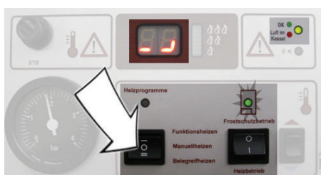
Afbeelding: Programmekeuzeschakelaar op "0" zetten
